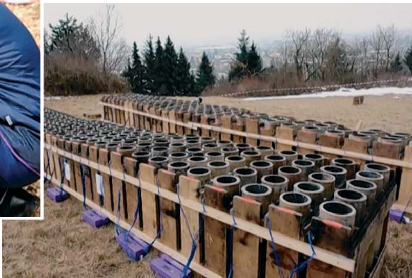
Aufbau und Verdrahtung einer Abschussrampe mit den Zündsteuergeräten
